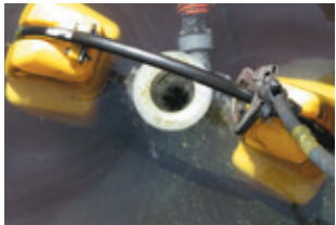
ねじ込みで高さを調節 (ゲートリング部は固定)
