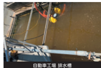
自動車工場 排水槽
