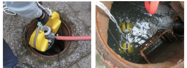
社員食堂からの雑排水の浮上油をマンホールピットから回収
